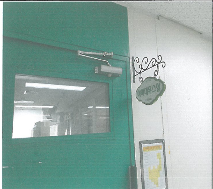
3층 아마데우스 출입 도어클로저 탈락 보수
