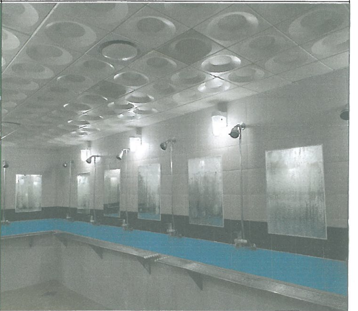
수영장 남자 샤워실 전구 2개 교체
