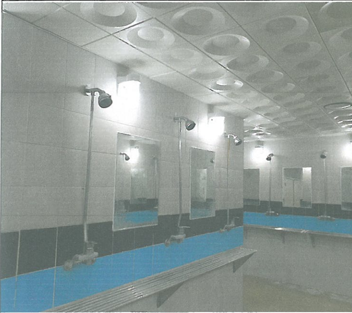
수영장 남자 샤워실 전등 1개소 교체
