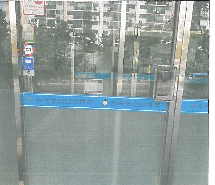
캡스 단말기 이동 랜선 재 가설 방우 케이스 공사
