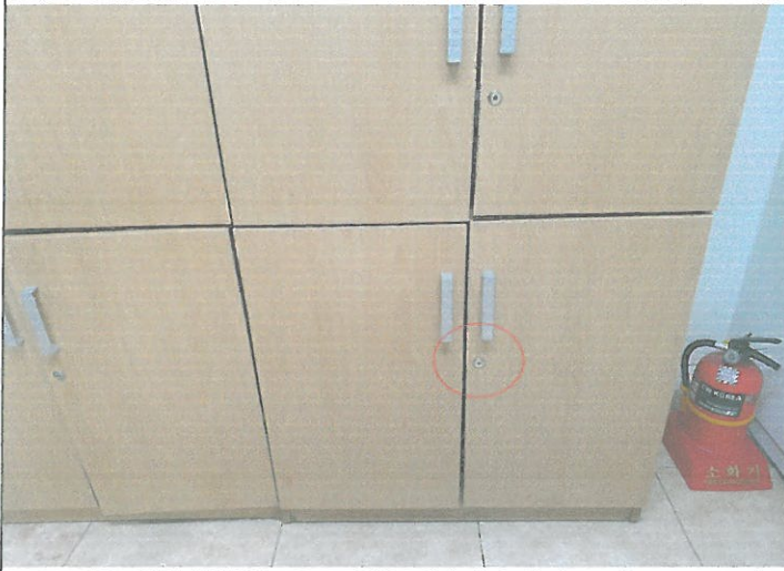
2층 복도 개인 사물함 열쇠 1개소 교체
