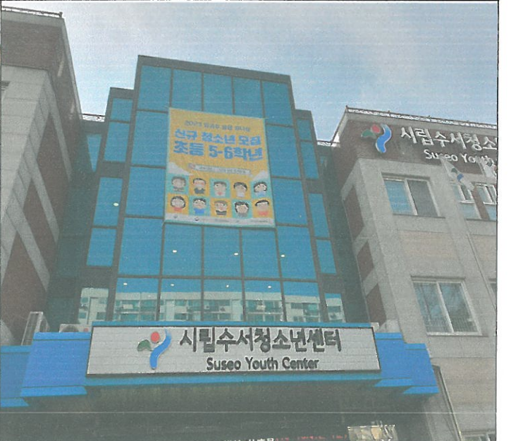
건물 외부 전면 앞 대형 현수막 설치 작업
