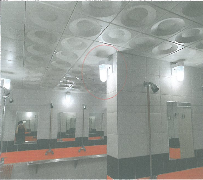
수영장 여자 샤워장 내 벽등 전구 1개소 교체
