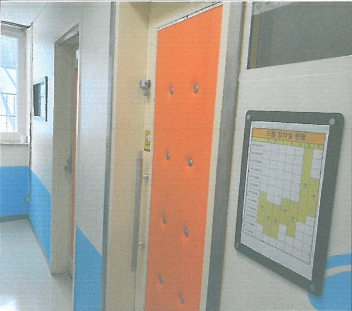
3층 드럼연습실 출입 문 시건경첩 파손 수리
