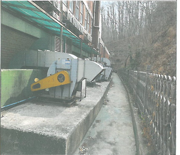
건물 후면 각종 배기팬 점검 구리스 주입
