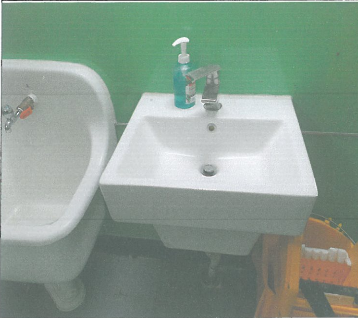
지하 1층 여자 화장실 세면대 팝업교체 및 통수
