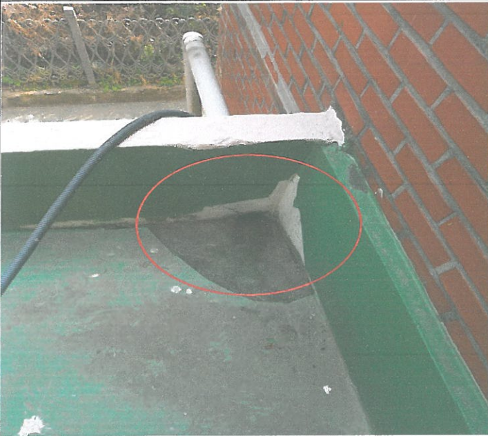
대체육관 산쪽 출입문 천장 배수관 우레탄 막김 통수
