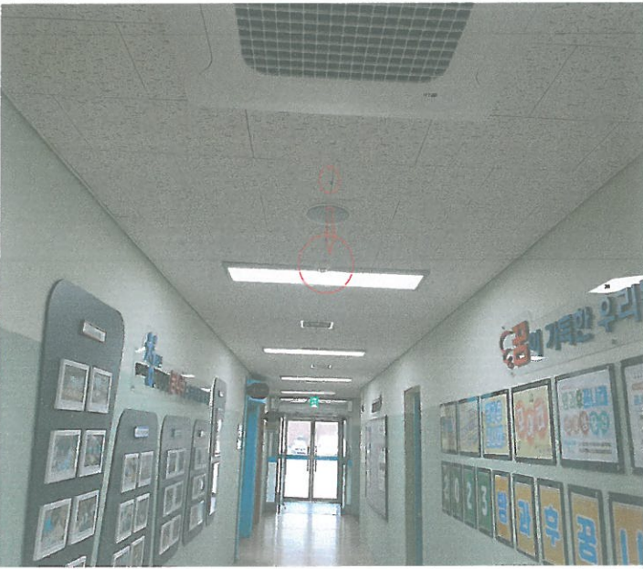
1층 주차장 출입구 복도 연기 감지기 이동 조치
