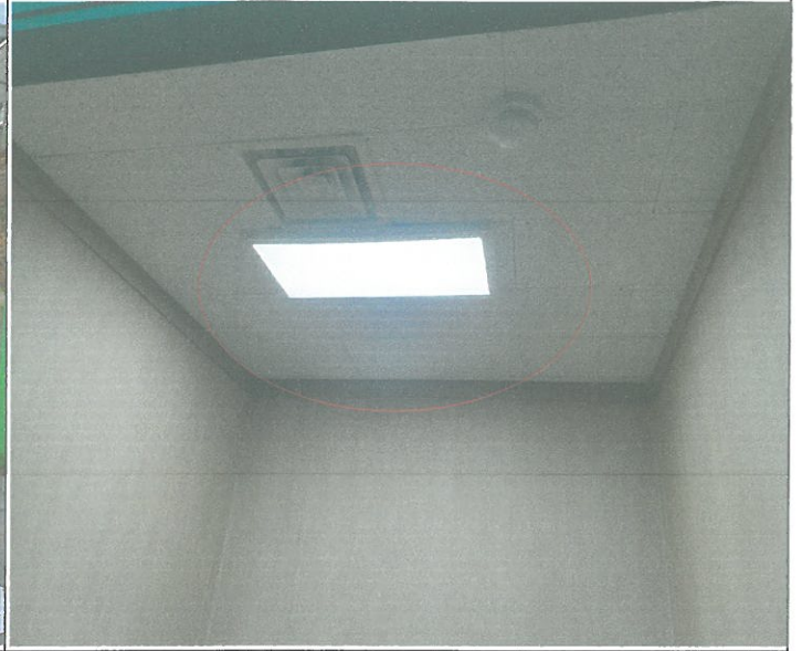
3층 피아노실 방 8개소 천장 직부등 교체
