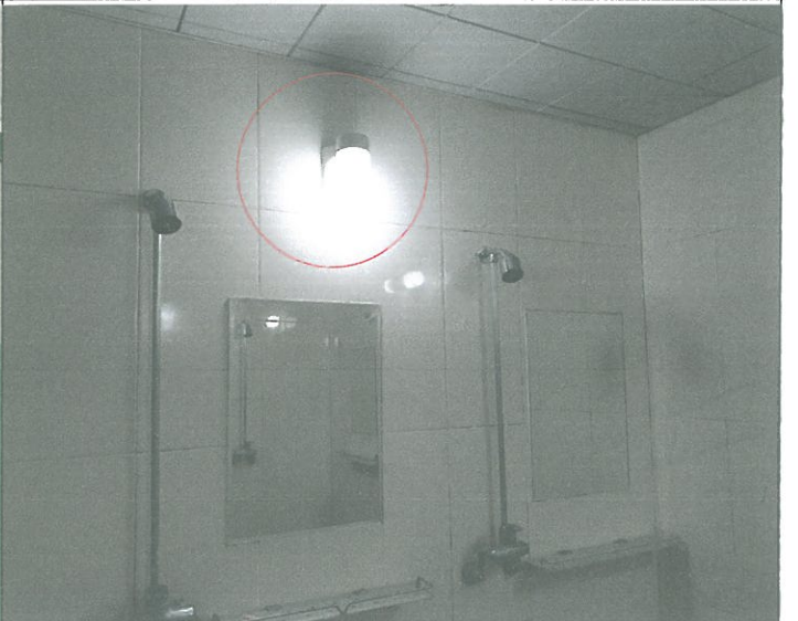
1층 대체육관 남자 샤워장 내 벽 전구 1개소 교체
