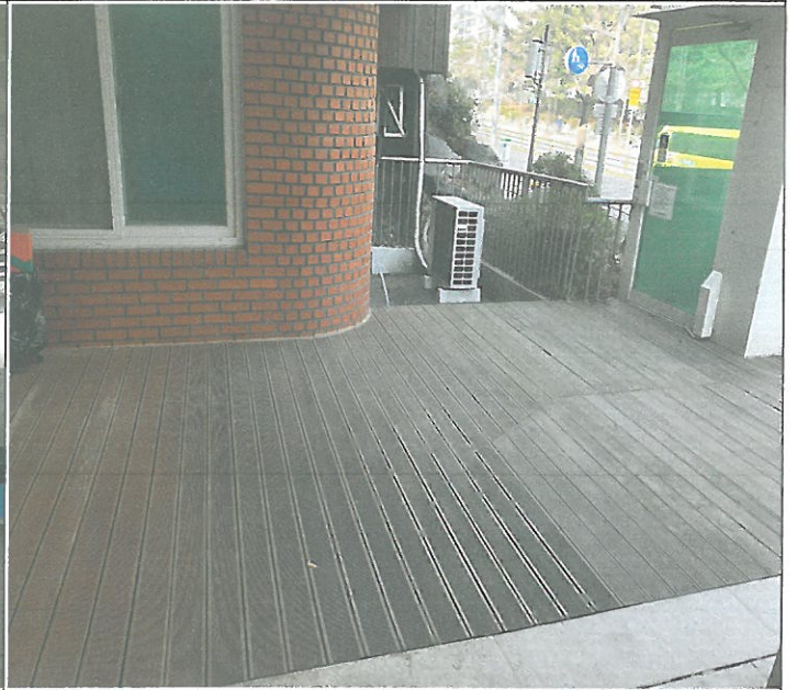
수영장 외부 테라스 방부목 손상 개소 보수작업
