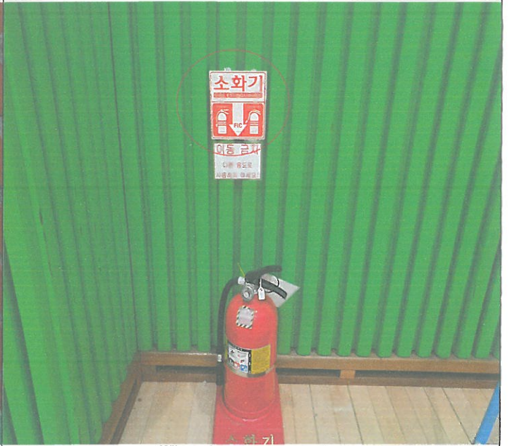
대체육관 소화기 스티커 탈거 분실 제 부착 1개소
