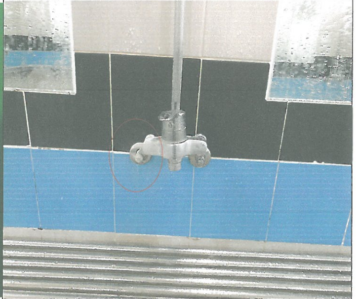
수영장 남자 샤워실 수전 누수 1기 수리
